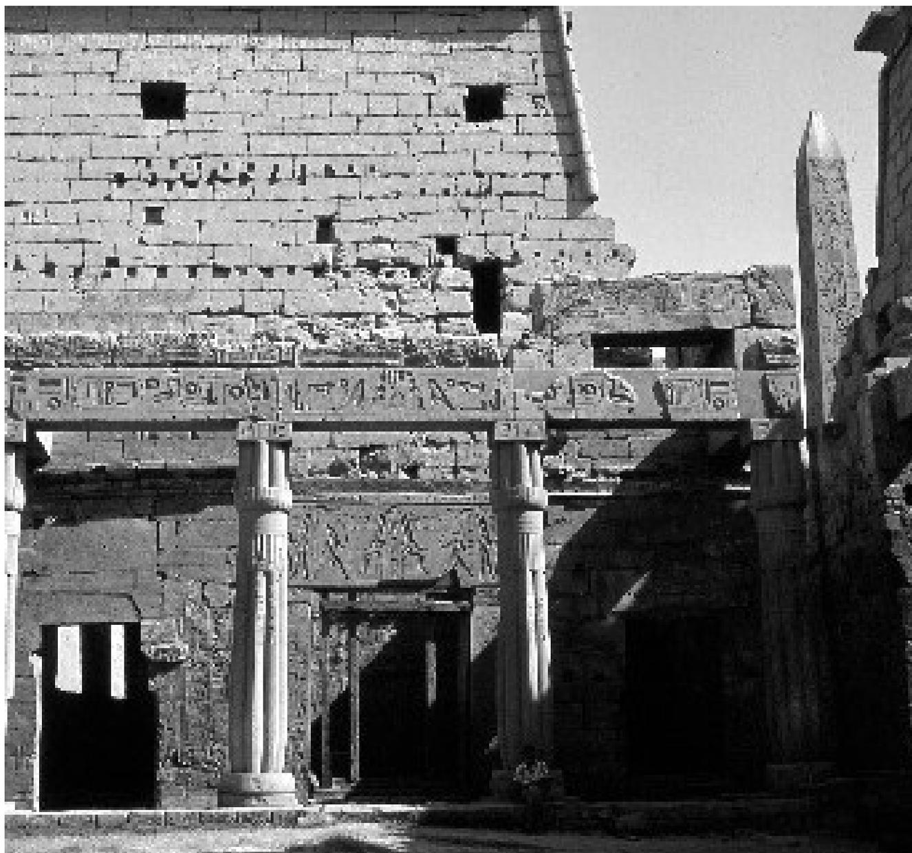
FIGURA 98. Primer patio del templo de Luxor. En la parte posterior del pilono, tras la sala de las barcas de Hatshepsut, se ven los mechinales donde se alojaron las cabezas de vigas de viviendas adosadas al pilono posteriormente. Las alturas marcan niveles de ocupación, y no diferentes pisos de una sola vivienda.
